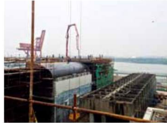
混凝土浇筑施工现场
