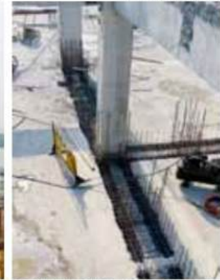
新的墙体结构夹住原始结构 (梁、柱)插入地下
