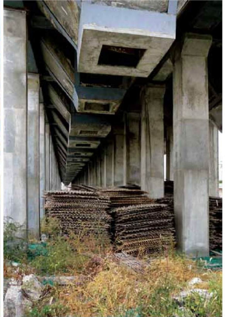
原运煤码头与煤料斗卸载桥
